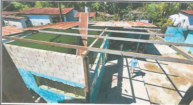
Foto 1: SUSTITUCION DE ESTRUCTURA DE METAL Y LAMINA EN TECHO DE AULA, COCINA Y CORREDOR
