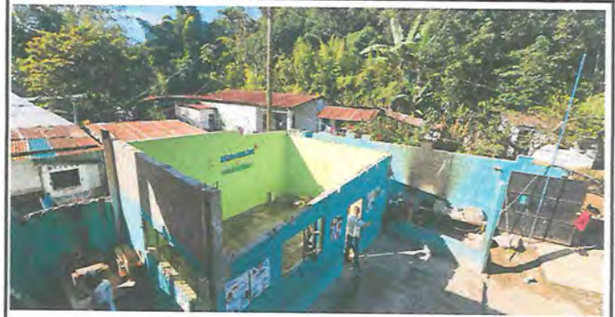
Foto 2: SUSTITUCION DE ESTRUCTURA DE METAL Y LAMINA EN TECHO DE AULA, COCINA Y CORREDOR
