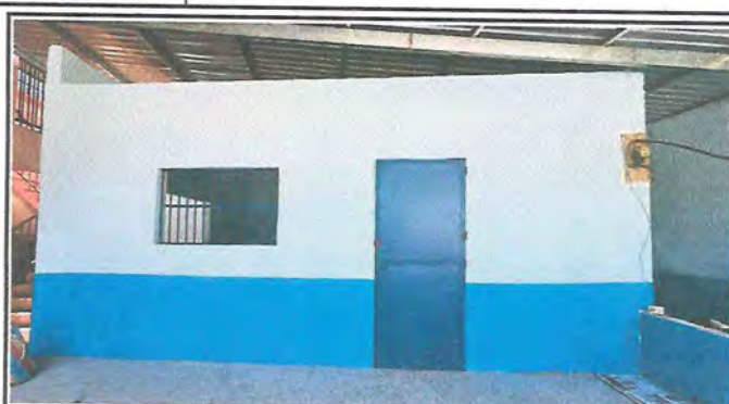
Foto 2: APLICACIÓN DE PINTURA GENERAL
