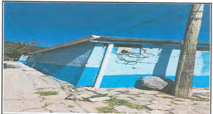
Foto 4: INSTALACION DE CANAL COLONIAL
