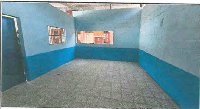
Foto 3: APLICACIÓN DE PINTURA GENERAL
