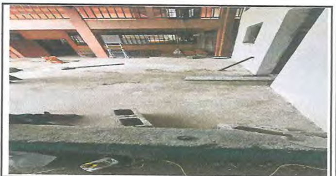
Foto 6: INSTALACION DE PISO DE GRANITO
