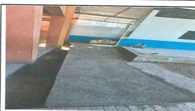
Foto 4: FUNDICION DE LOSA EN GRADA DE PATIO
