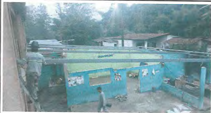
Foto 3: INSTALACION DE ESTRUCTURA DE METAL Y LAMINA EN TECHO DE AULA, COCINA Y CORREDOR
