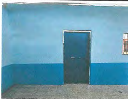
Foto 3: SUSTITUCION DE PUERTA DE AULA
