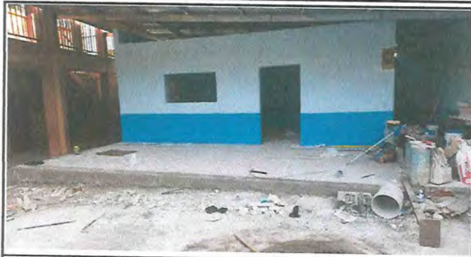
Foto1: APLICACIÓN DE PINTURA GENERAL
