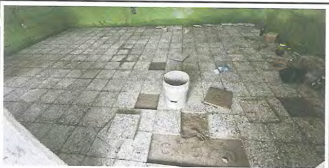
Foto 5: INSTALACION DE PISO DE GRANITO
