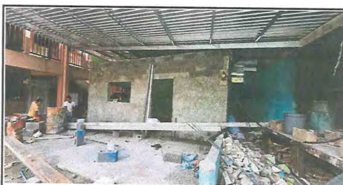
Foto 6: NIVELACION DE PAREDES EN AULA
