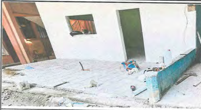
Foto 1: INSTALACION DE PISO DE GRANITO
